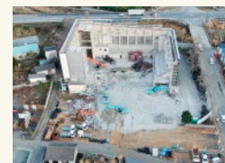
双葉町公民館・体育館の解体作業
