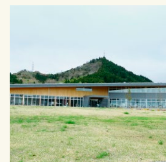
大熊町役場の 太陽光発電設備設置
